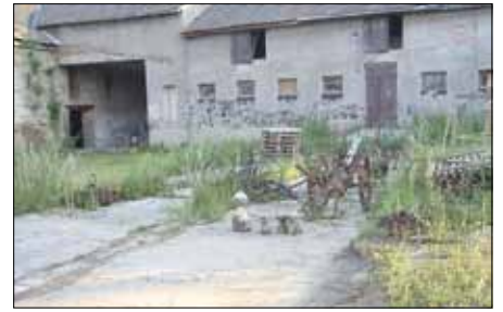
Umbau des ehemaligen Fuhrmann- schen Gutes zum Hof der Gewerke
