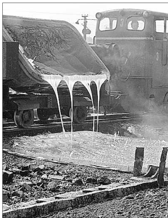
Gießen von Schlackensteinen, Schlackenplatz der neuen Krughütte, Quelle: MBB-Archiv
