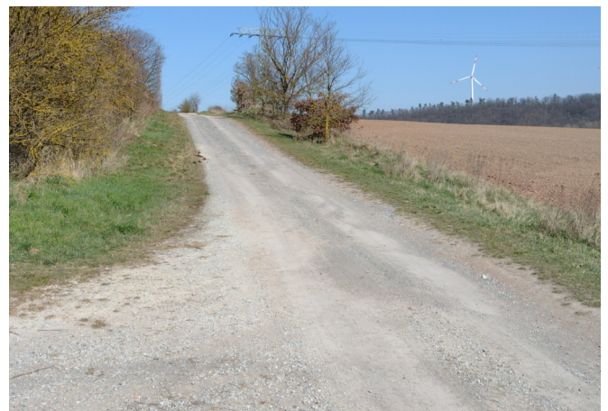
Feldweg zwischen Blankenheim und Kreisfeld bzw. Wimmelburg: Mangelhafter Belag
